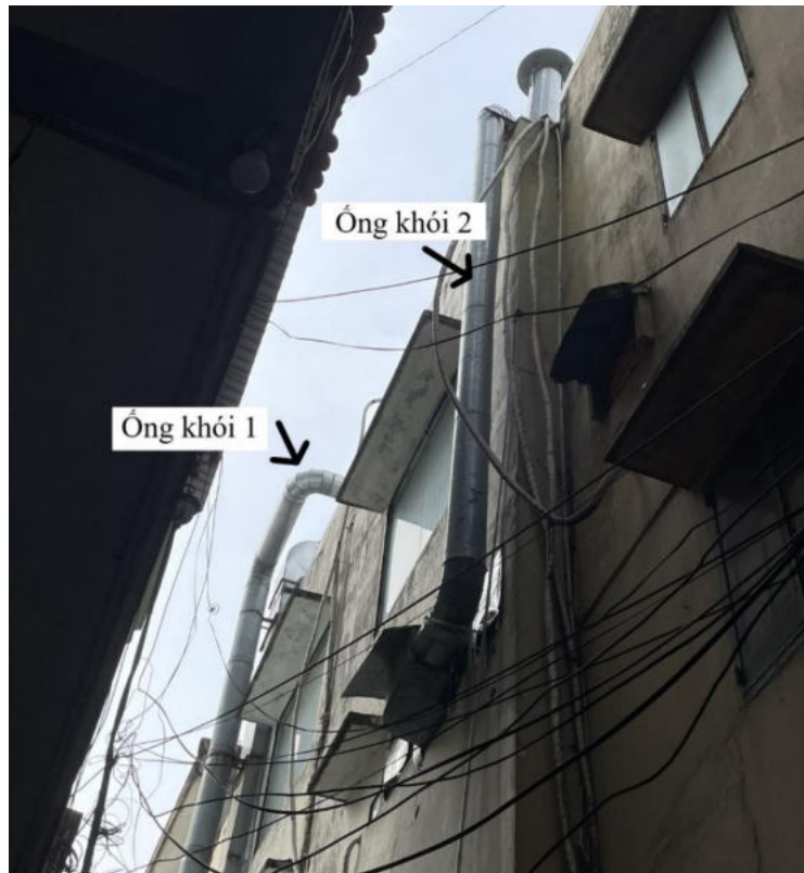
Hình 14. Vị trí ống khói thải nhà bếp
